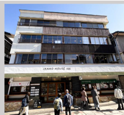
築 100 年超の旧旅館を 飲食・体験などの複合施設に改修
